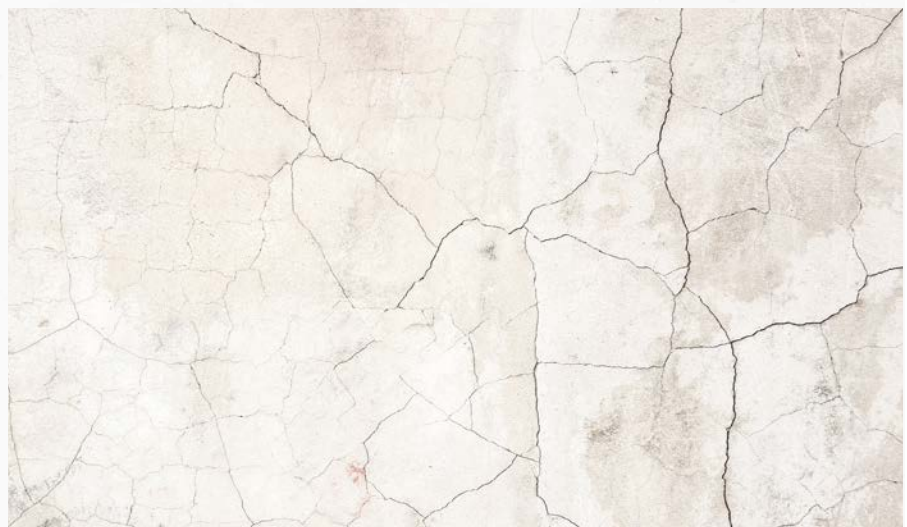
Netzförmige Risse entstehen, wenn kein ausreichender Verbund zwischen den einzelnen Putzschichten vorhanden ist.
