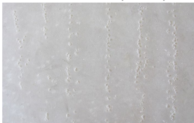
Abb. 19: Beispiel für die Bläschenbildung an der Oberfläche von Fließestriche
