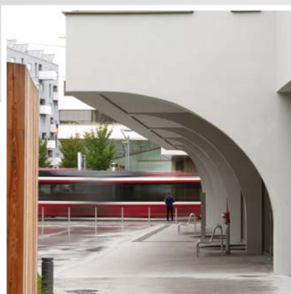
Im Erdgeschoss wurden Bögen errichtet um den freigehaltenen Raum des Erdgeschosses hervorzuheben.
