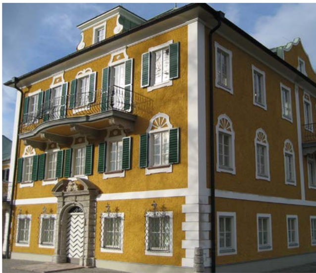
Die Fassade des Gwandhauses wurde mit einem mineralischen, widerstandsfähigen Edelputz versehen.
