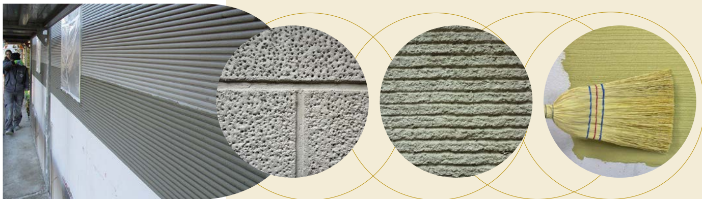
Traditionelle Putztechniken wie Kammzug, Nagelbrettputz, Rechenstrichputz und Besenzug (v. li.) erzeugen eine charakteristische Struktur.
